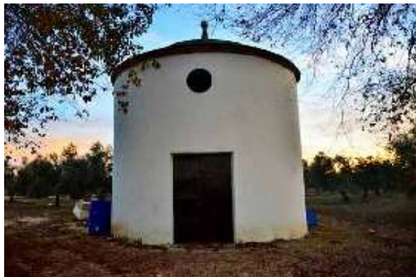
Pozo del Término (J. Torres Garrido, diciembre 2016)
