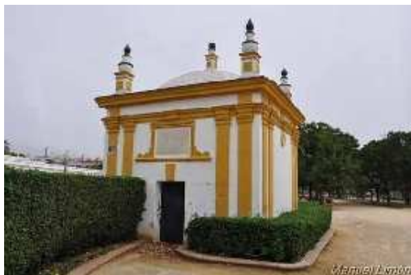
Caja de Aguas (M. Limón Andamoyo, agosto 2016)
