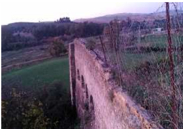
Acueducto de la Molineta (J. J. Portillo Ramos, diciembre 2015)
