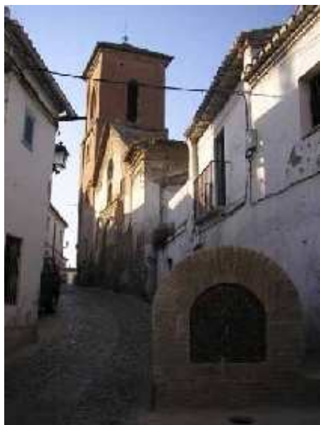
Aljibe de San Luis (static.panoramio.com-J. Canales, agosto 2009)
