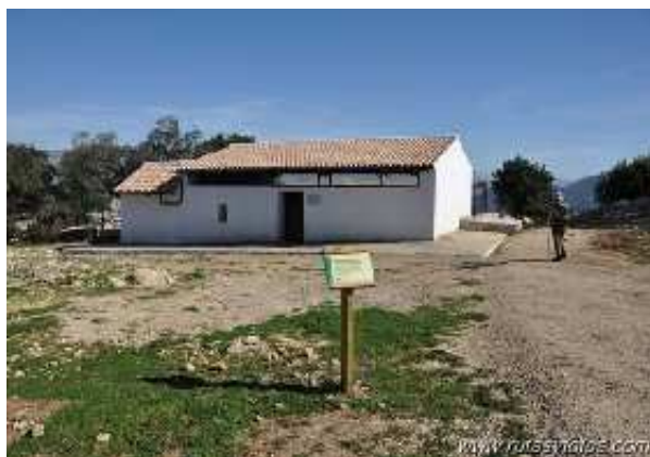
Aljibe del Aprisco Lomas de Albarracín (M. Limón Andamoyo, abril 2015)
