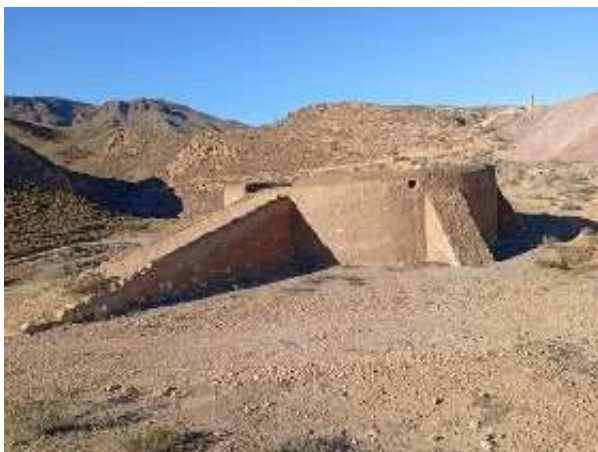
Vista del edificio con la rampa de acceso (J. M. Galindo, febrero 2025)
