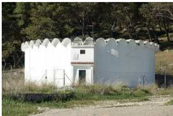
Depósito Las Canteras (M. Limón Andamoyo, marzo 2023)
