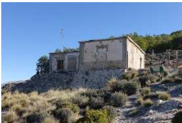
Casilla del Agua (M. Limón Andamoyo, noviembre 2023)
