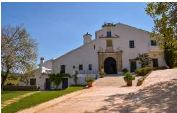
Fachada principal de Los Pozos de la Nieve, Caserío barroco del s. XVII rehabilitado como modelo de alojamiento rural sostenible (A. Márquez Pascual, mayo 2022)
