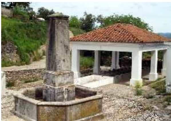
Fuente-lavadero de Puerto Gil (A. Castillo)
