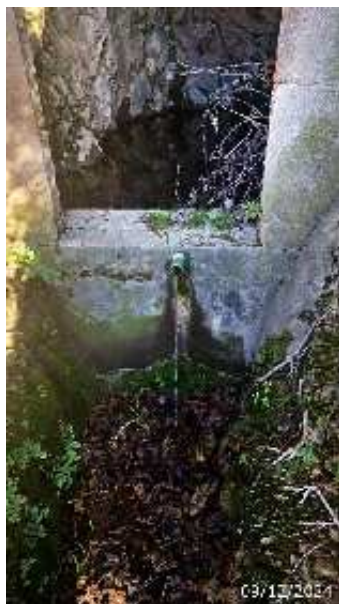
Manantial represado, con un caño de rebosadero que hace de fuente (A. Ventas, diciembre 2024)
