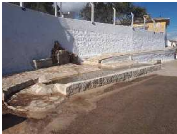
Lavadero del Arroyo, rehabilitado (J. D. Cano Cavanillas, noviembre 2019)
